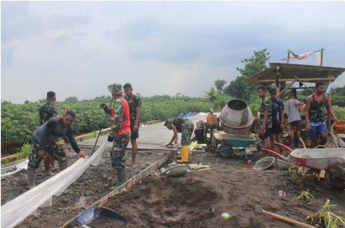
Fungsi dari plastik tersebut adalah untuk mendapatkan hasil beton dapat mengeras dengan sempurna karena air semen tidak merembes ke dalam tanah.
